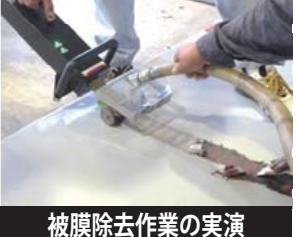
テクノヒートによるゴムライニング除去
